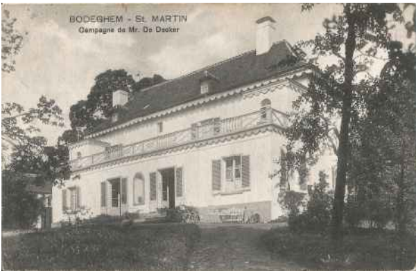
Postkaart Schaillée met de onder Powis de Tenbossche aangebouwde achterbouw met bovenliggend terras. Op het terrasniveau ziet men uiterst links en rechts de uitbouwen voor badkamers (foto ca. 1912, uit de tijd van De Decker).
